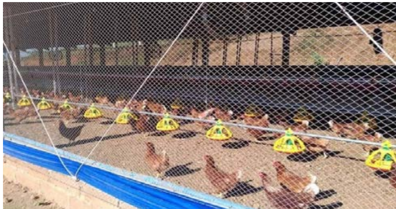
Os galpões abertos podem ser transformados em galpões ventilados, instalando cortinas nas paredes abertas/laterais. Muitas vezes é rentável e pode beneficiar das vantagens de ambos os sistemas.
