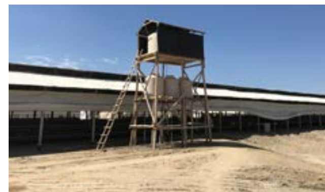
Pintar o reservatório de água de branco permitirá um melhor arrefecimento da água, uma vez que o calor é refletido em vez de absorvido. Além disso, um depósito de água pintado de branco resultará num melhor arrefecimento do depósito de água.
